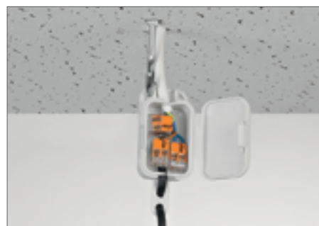
Подвесное присоединение светильников в подвесных потолках
